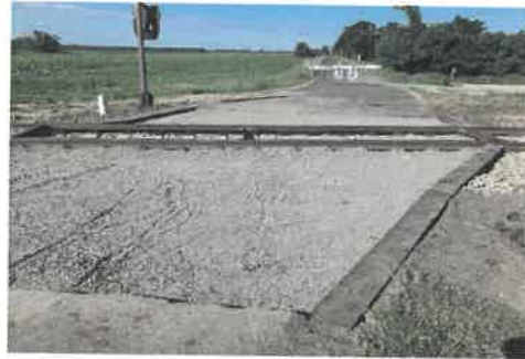
Prípravné práce pred asfaltovaním
