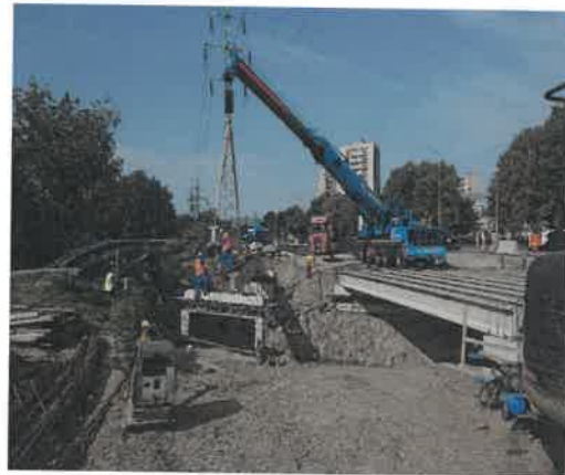
Pokládka nosníkov na lávku
