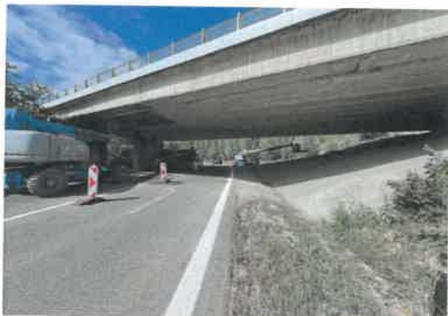
Ukončovanie sanácie mosta
