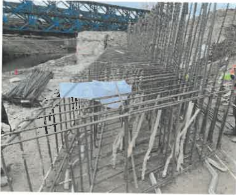
Viazanie armatúry opory 1. mosta
