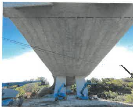
Ukončenie sanácie mosta
