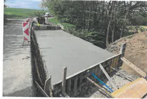
Betonáž sprisahajúcej dosky.
