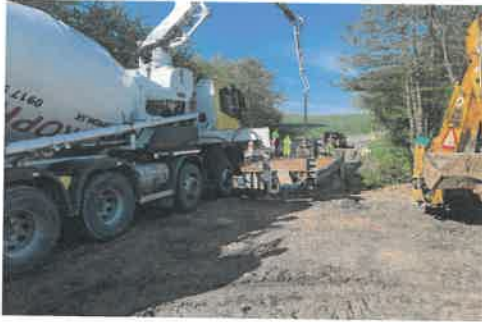
Betonáž podkladného betónu (pod záverný múr).
