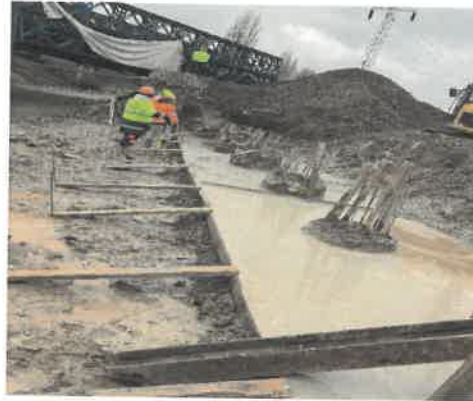
Betonáž podkladovej dosky opory 1 mosta
