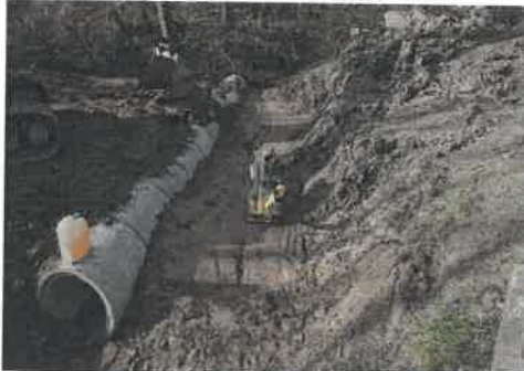
Obsyp potrubia, zhotovenie násypu v obchádzkovej trase mosta.
