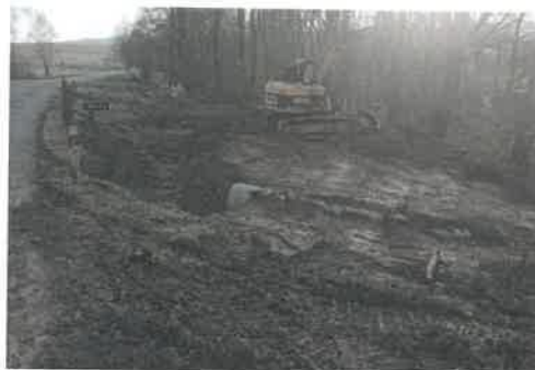
Zhotovenie podkladových vrstiev obchádzkovej trasy
