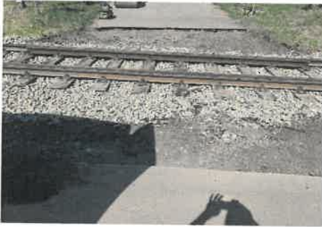
Príprava prác pred asfaltovaním
